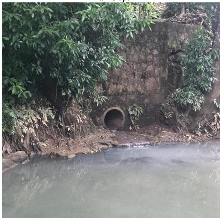
Fotografía No. 1. Desfogue provisional de aguas pluviales del area urbana, Chahal, Alta Verapaz
